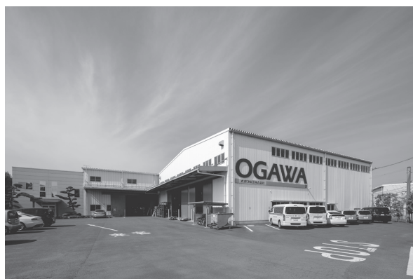
宮ノ陣新産業団地内にある本社事務所、工場
